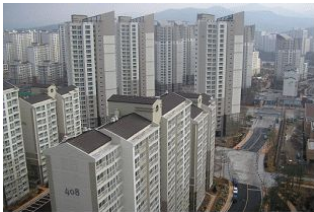
성남판교 아파트 건설공사 8공구
